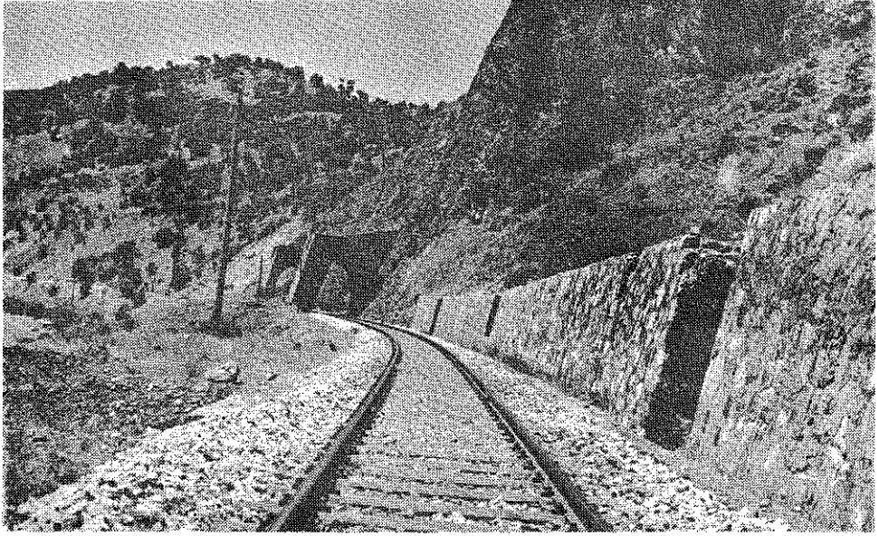
Foto 4 — Turna istasyonunun batı kesiminde bazalt kayalarının akıntıları ve demiryolu kenarına yapılmış istinat duvarı (Atalay 1973).
