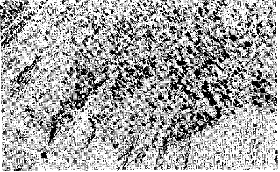
Foto 1 — Muş-Elâzığ demiryolunun 119-120. km. leri arasında dik açılmış şevler boyunca göç eden yamaç depoları (Atalay 1973).
